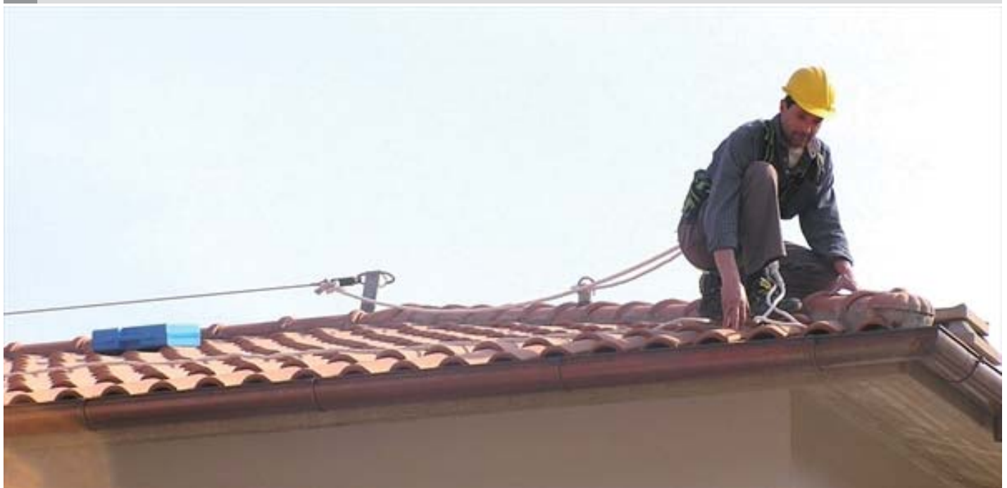
Fig. 2b Seilsicherungs-System, Satteldach
