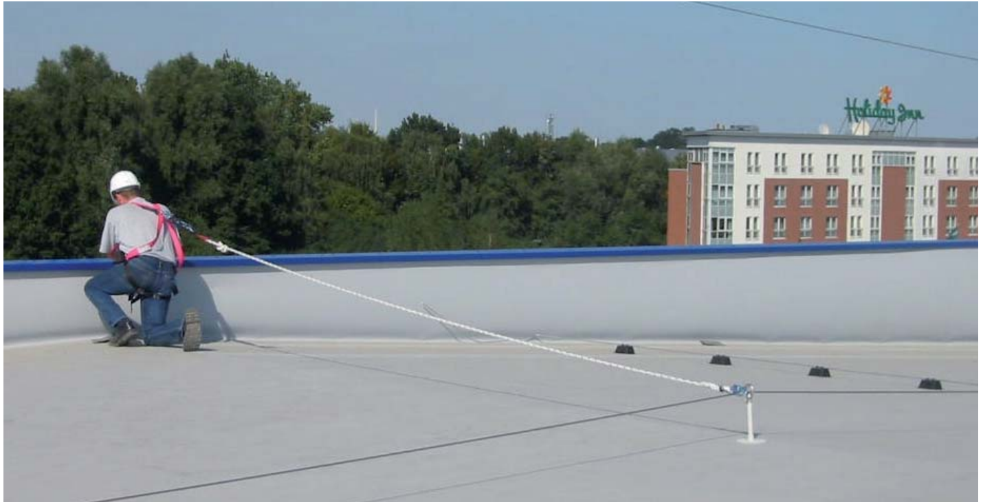
Fig. 2a Seilsicherungs-System, Flachdach
